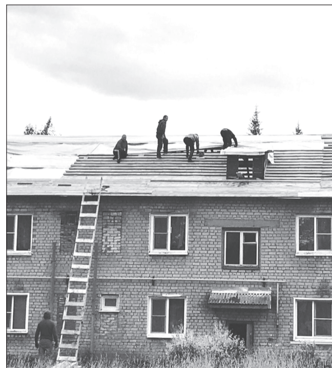
Фонд капитального ремонта провёл в селе Ингарь ремонт крыш двух МКД по переулку Спортивному. Вместо старого шифера - современный металлопрофиль плюс снегозащита
